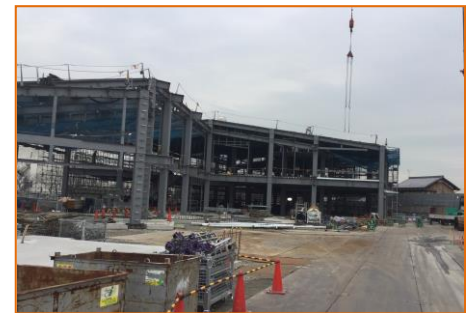
建物の骨組み
